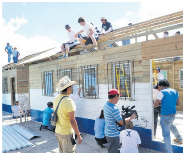
» Comunitarios, docentes y voluntarios suman esfuerzos para lograr en tiempo récord la edificación de Aulas en un Día.
