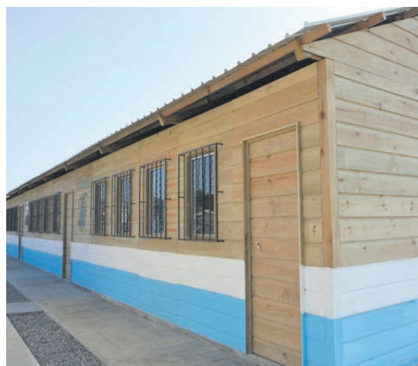
» En 2016 fueron construidas aulas en un día en Ciudad Peronia.
